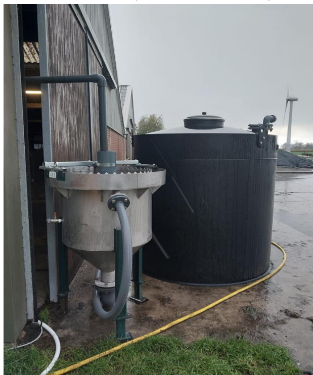
Figuur 2-1. Verplaatsbare vergister in de stal (links) plus een bezinker en opslagvat buiten de stal (rechts).
